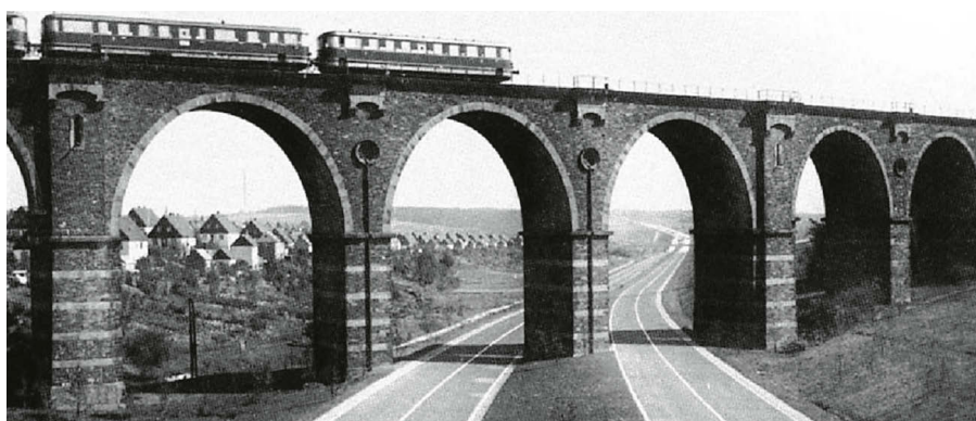
Bild 1. Historische Aufnahme, Westansicht des Bahrmühlenviaduktes (Foto: von M. Lambertz)
