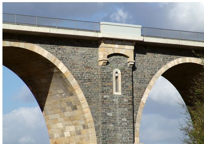
Bild 14. Anschluss Pfeiler/Bögen an neue Fahrbahn
