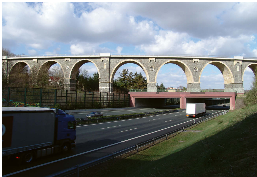
Bild 15. Bahrmühlenviadukt nach Instandsetzung und Ertüchtigung
